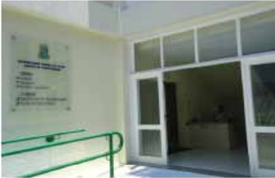
Entrada da Diretoria do CH – Área I
